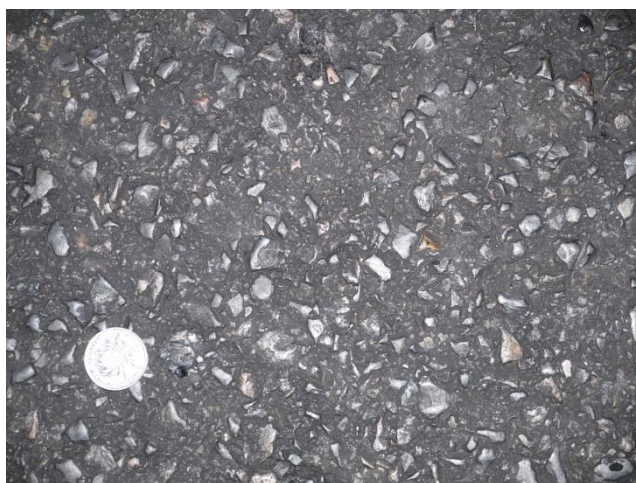
图 5.1 路面集料剥落图
