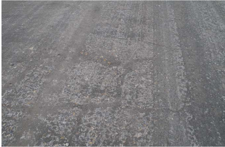
图 2.22 C 类损坏半刚性基层
