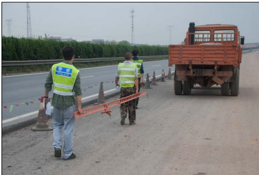
图 2.7 现场贝克曼梁检测弯沉
