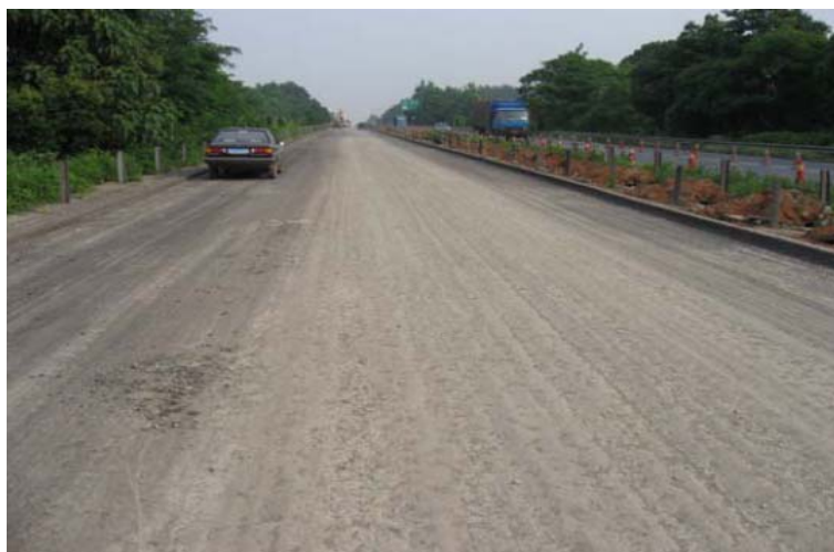
图 2.20 A 类损坏半刚性基层
